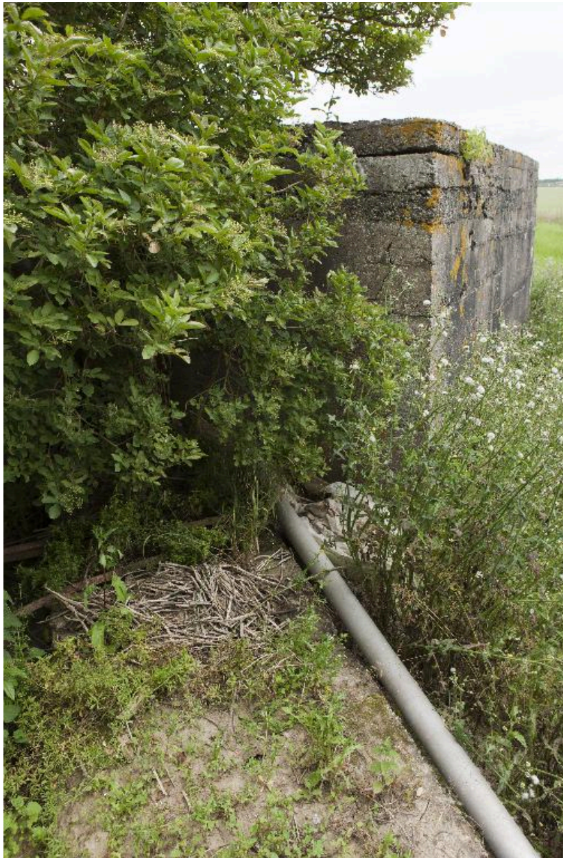
Rigole menant au bâtiment 1
