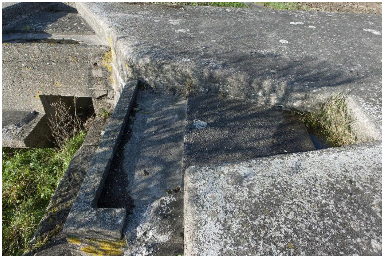
Cuve à mitrailleuse centrale
