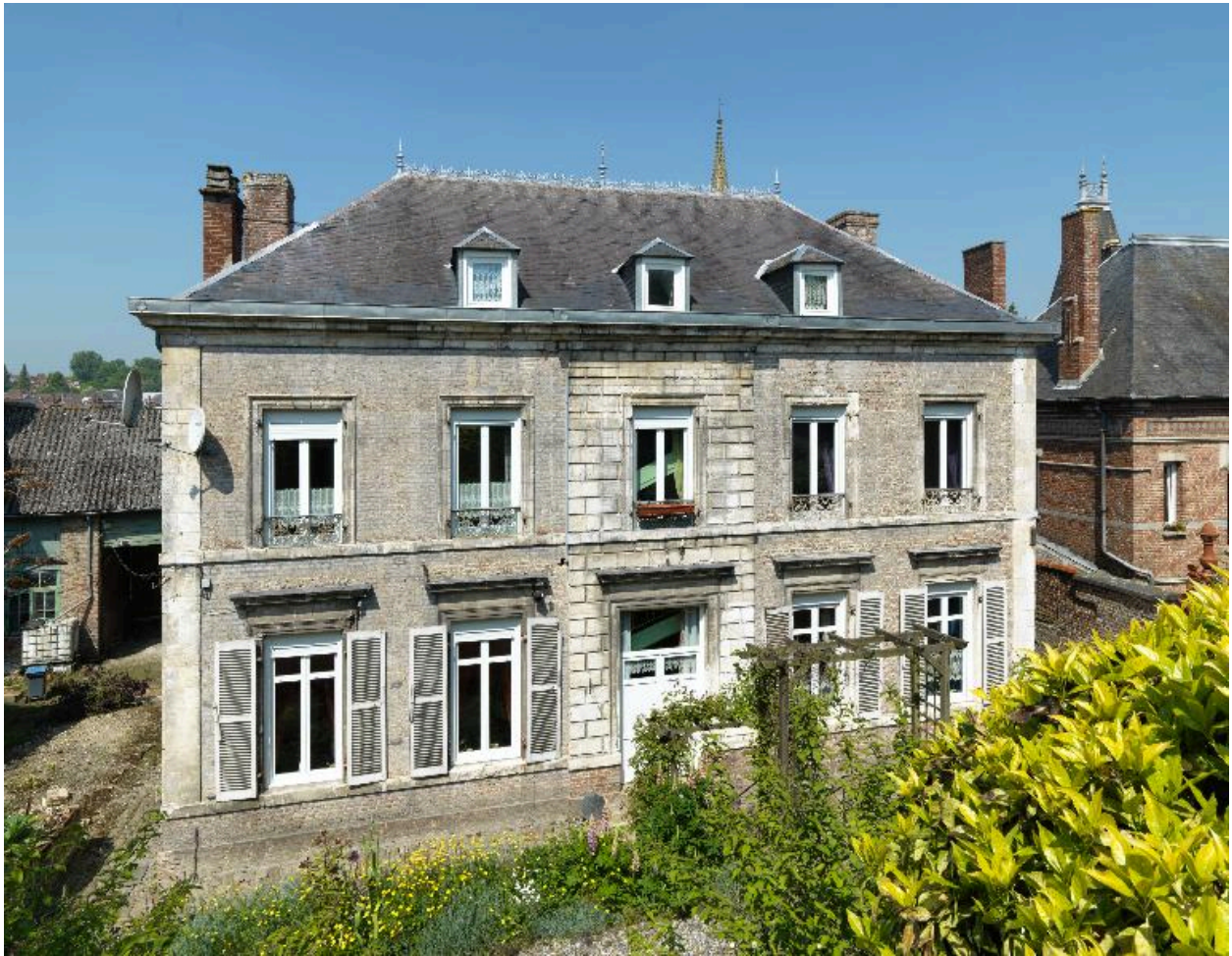
Façade postérieure, vue de face.
