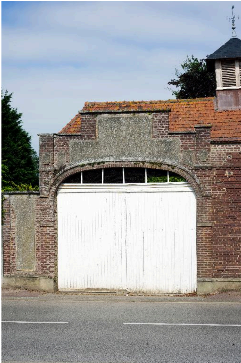
Vue du cartouche présent au dessus de l'ancienne porte d'accès aux anciens établissements A. Maclair, ateliers et fonderies du Vimeu.
