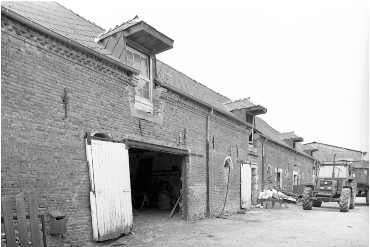
Vue d'ensemble de l'élévation sur cour de l'étable sud-est.
