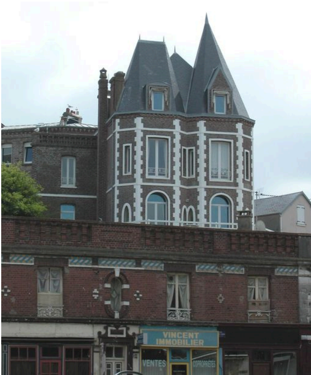
Vue d'ensemble depuis la rue Raspail.
