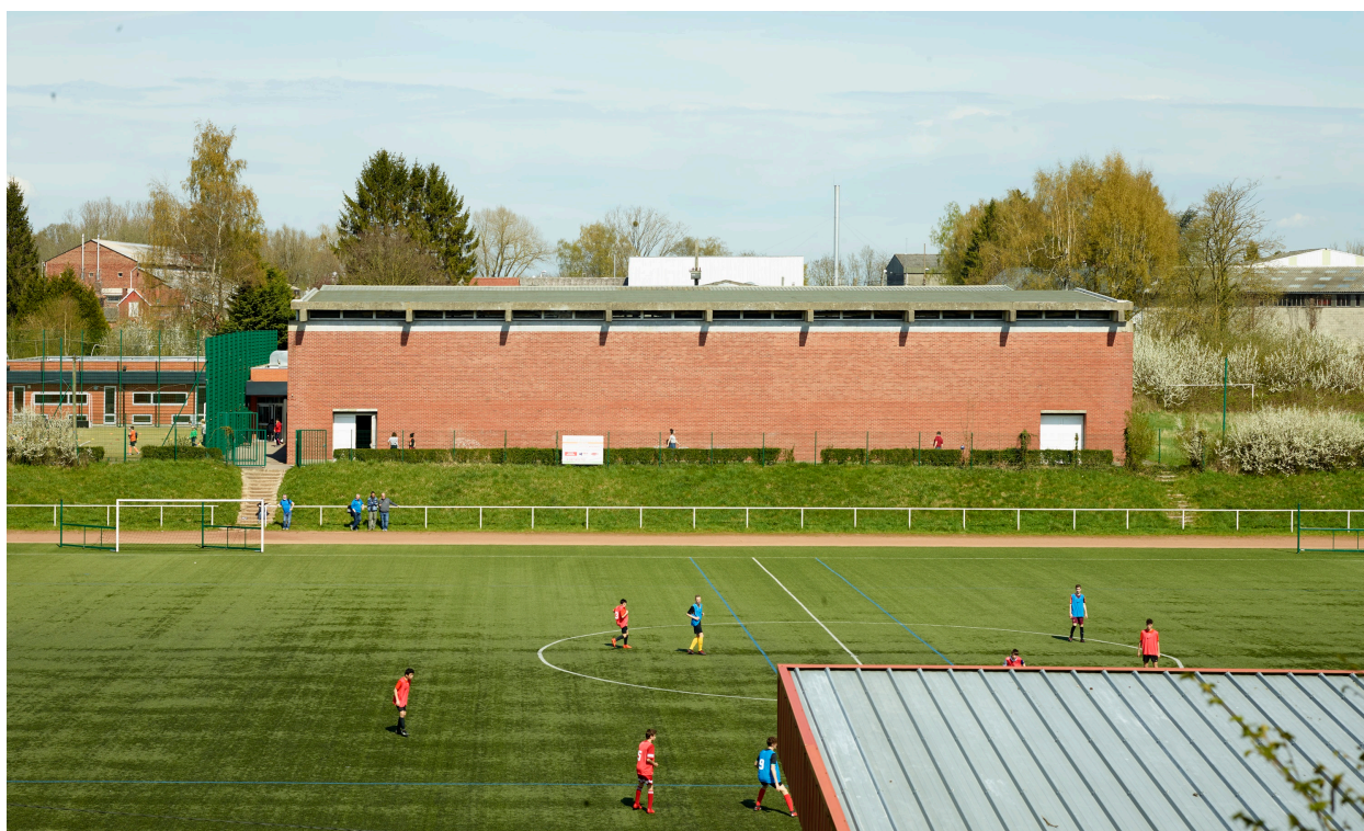
Gymnase de 1969 : vue du mur sud depuis les remparts, 2018.
