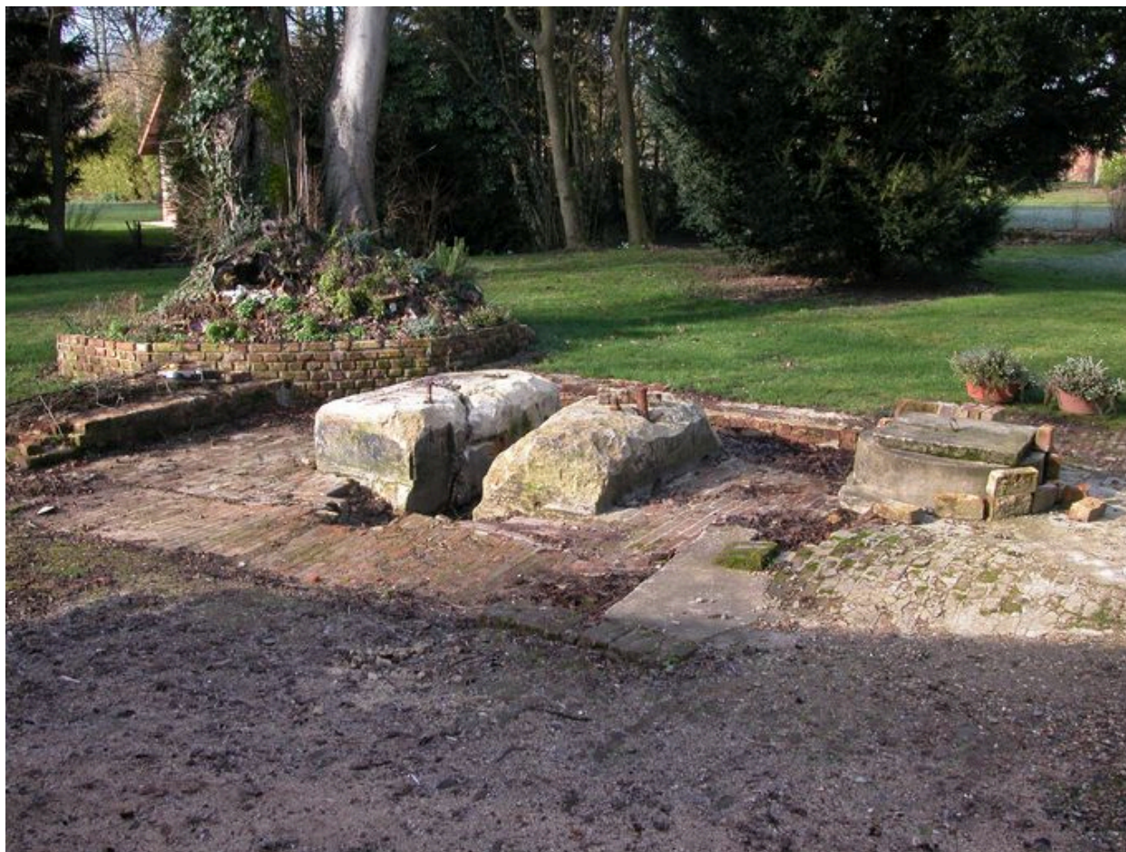
Vestiges de la salle des machine et du socle supportant
