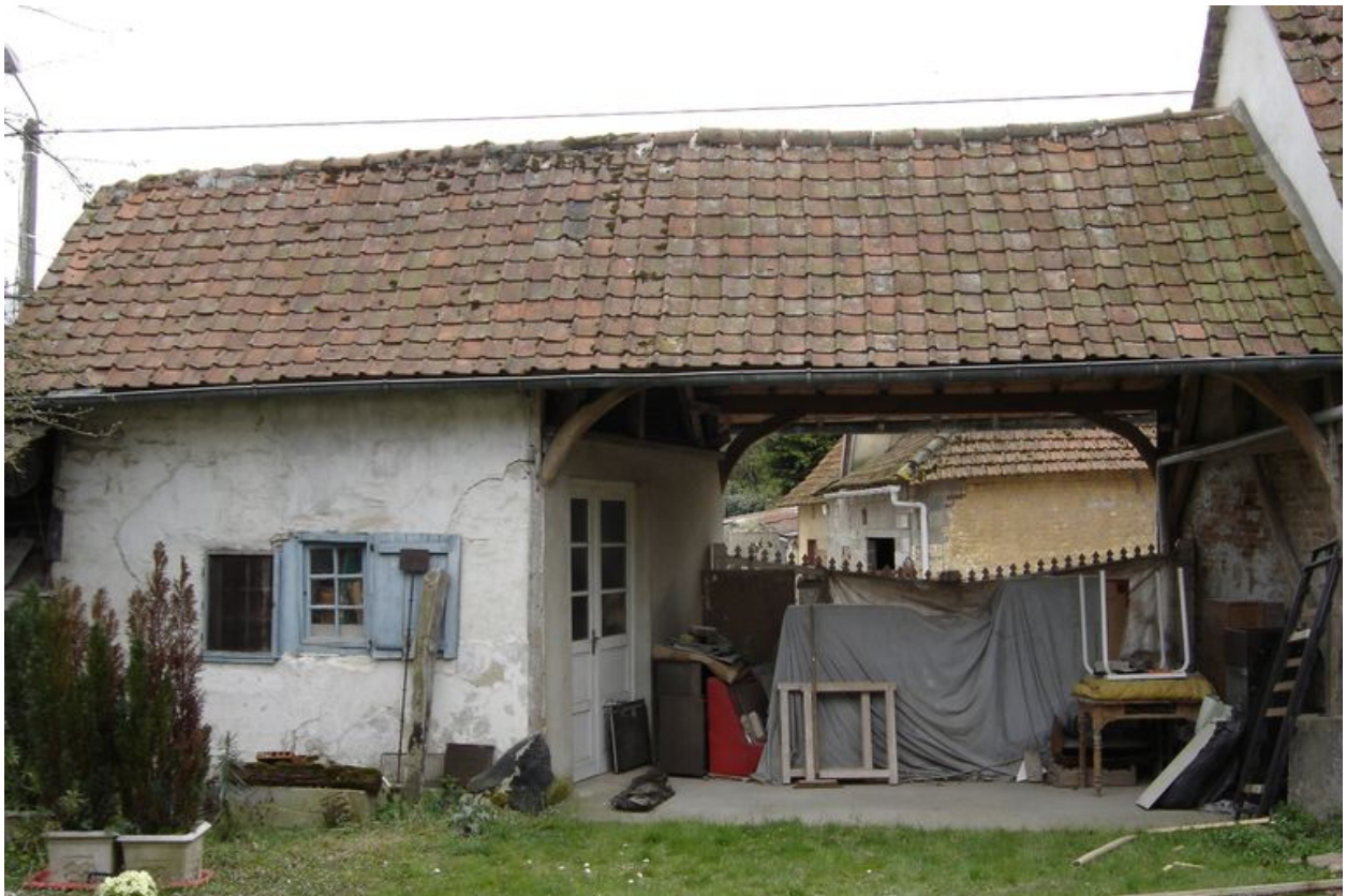
Vue du corps de passage depuis la cour.
