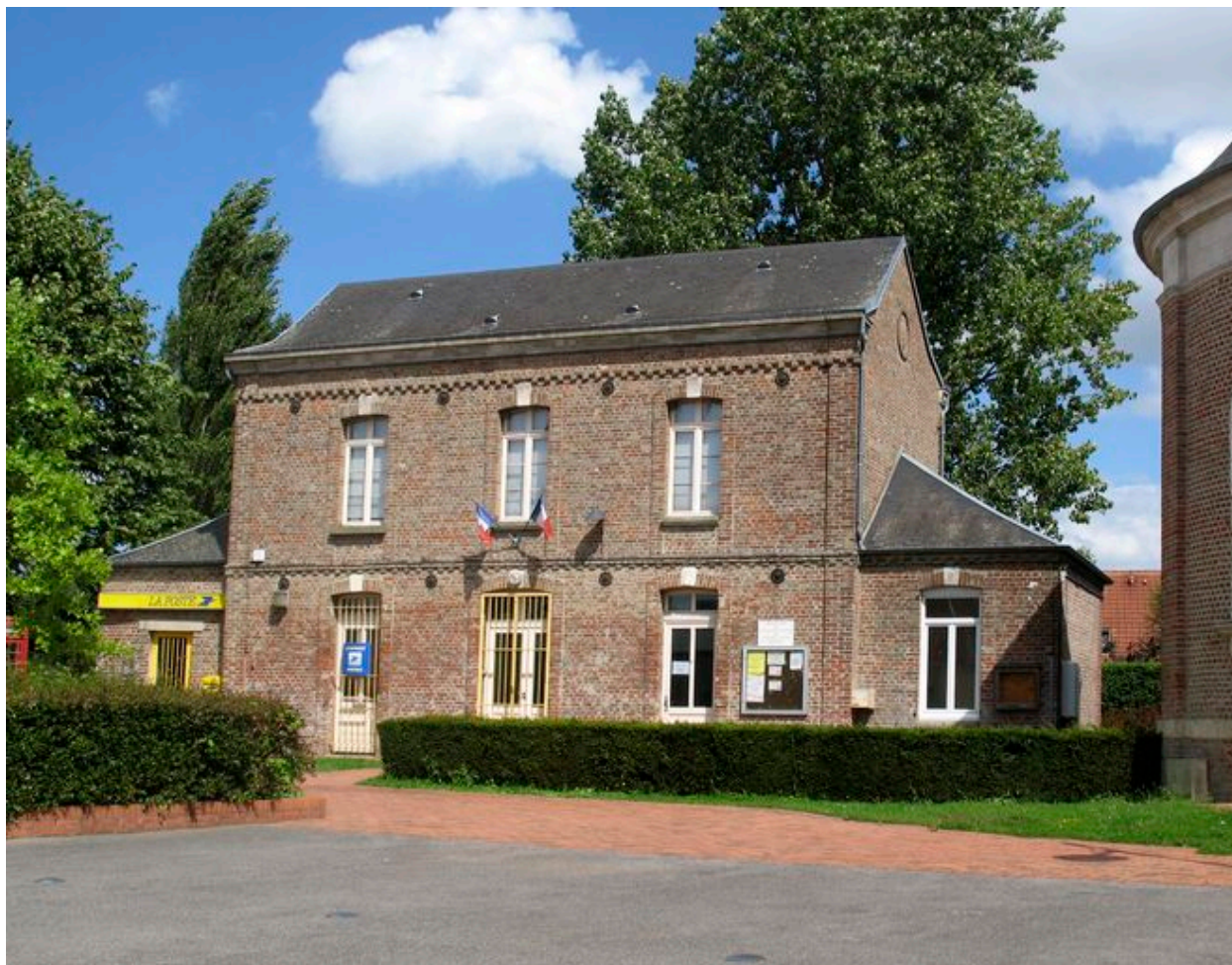
Vue d'ensemble de la façade principale.
