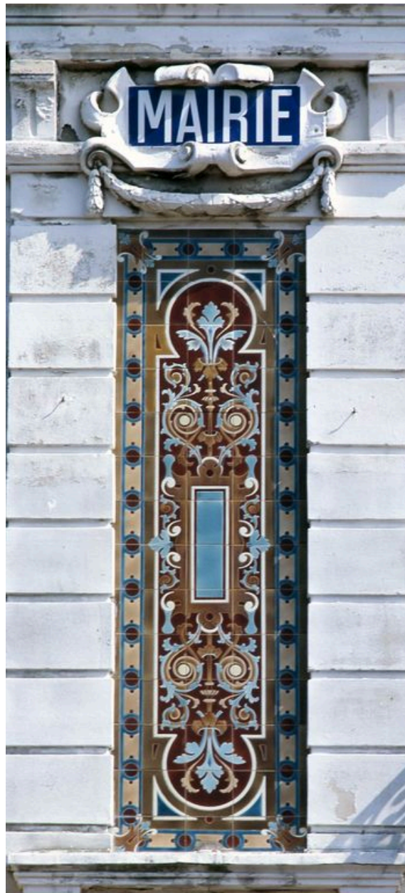
Détail du décor de céramique en façade antérieure.
