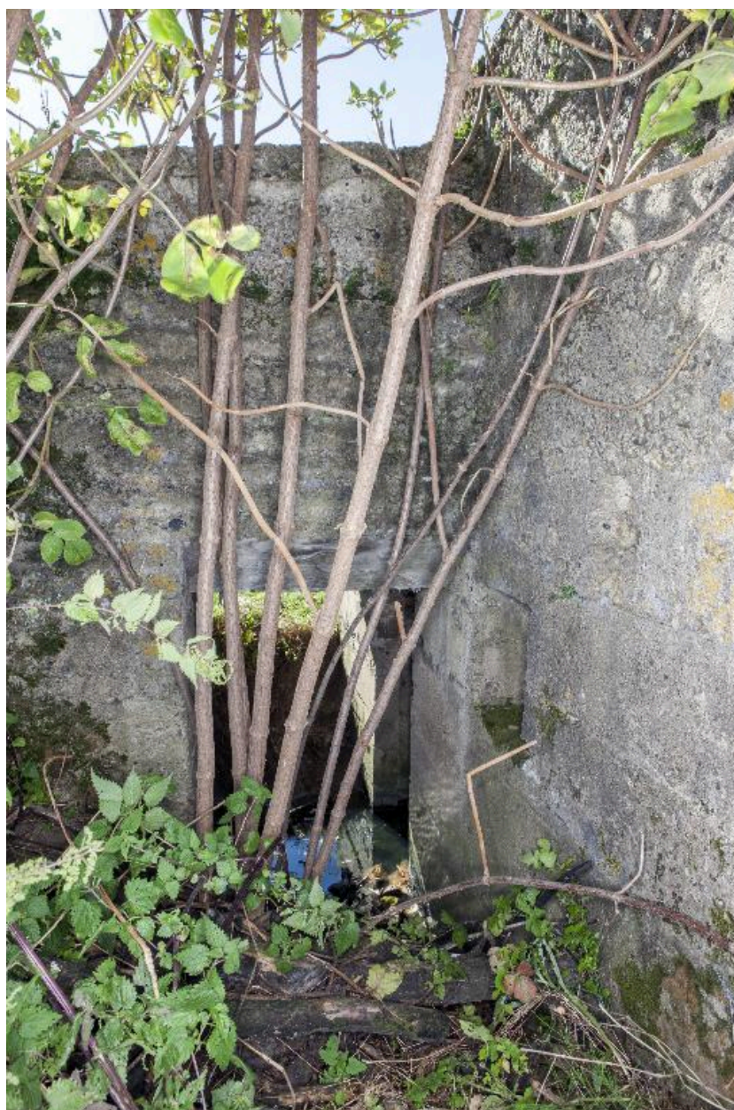
Entrée sud-ouest du porche pare-souffle
