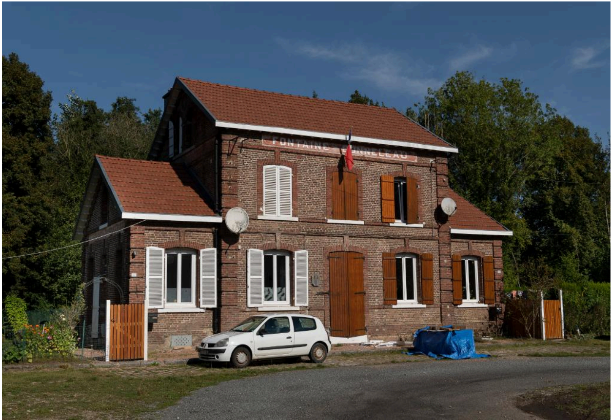
Vue générale depuis le sud-ouest de l'ancienne gare de Fontaine-Bonneleau, aujourd'hui maison.
