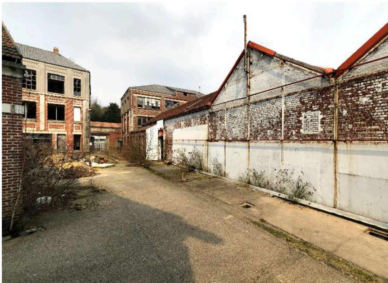
Vue d'ensemble du nord du site industriel.
