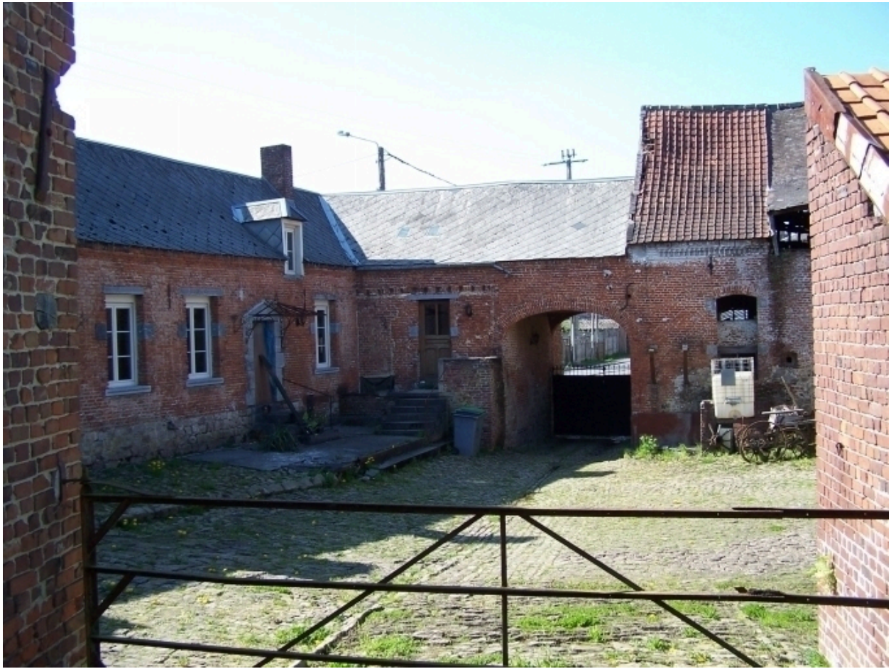
Vue de la cour de la brasserie.
