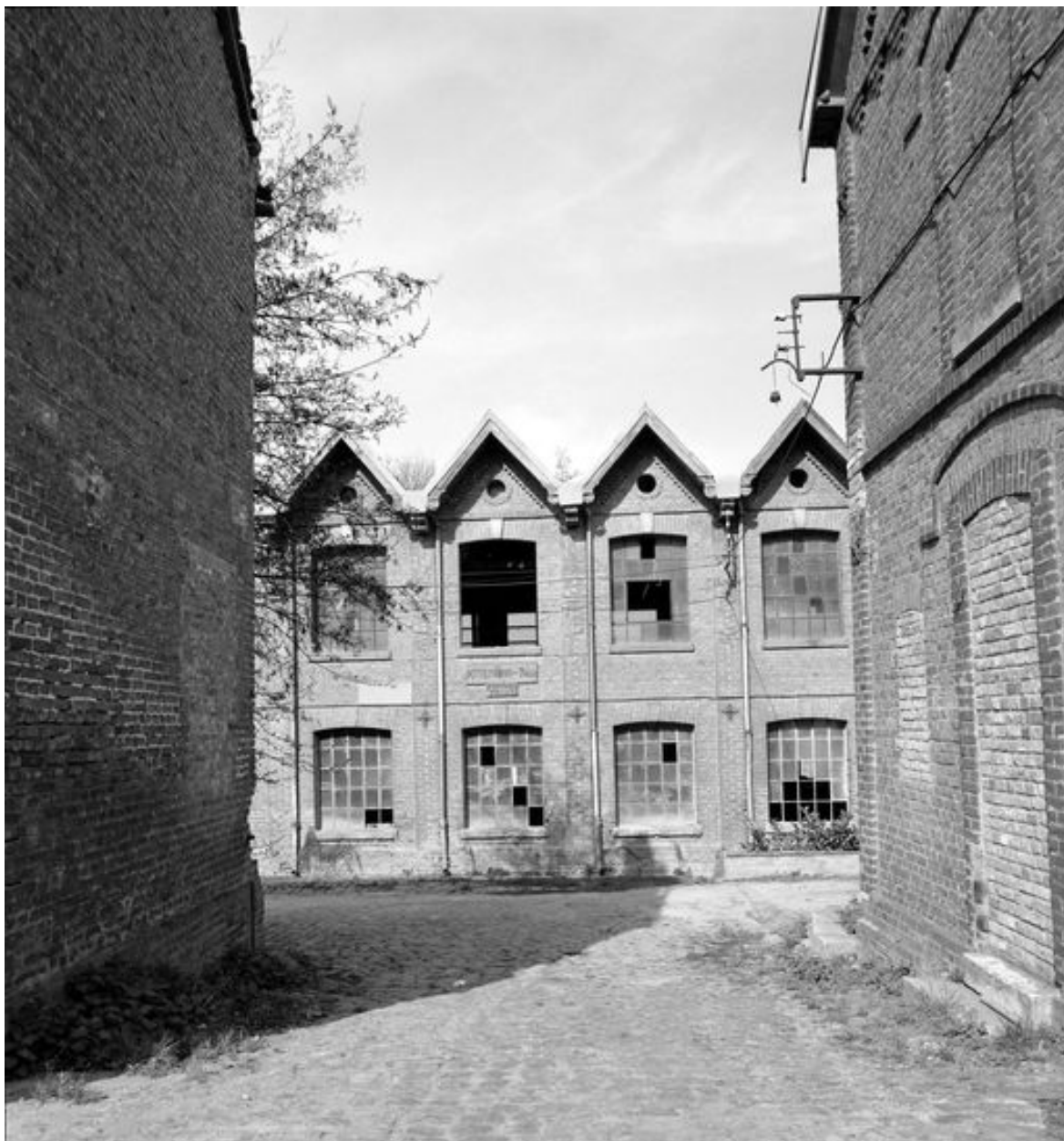
Ateliers de fabrication, flanc est détail.
