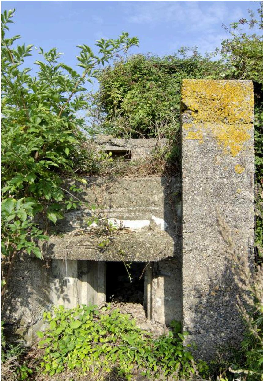
Position de tir sur le couverture et resserre de la mitrailleuse dans la partie basse
