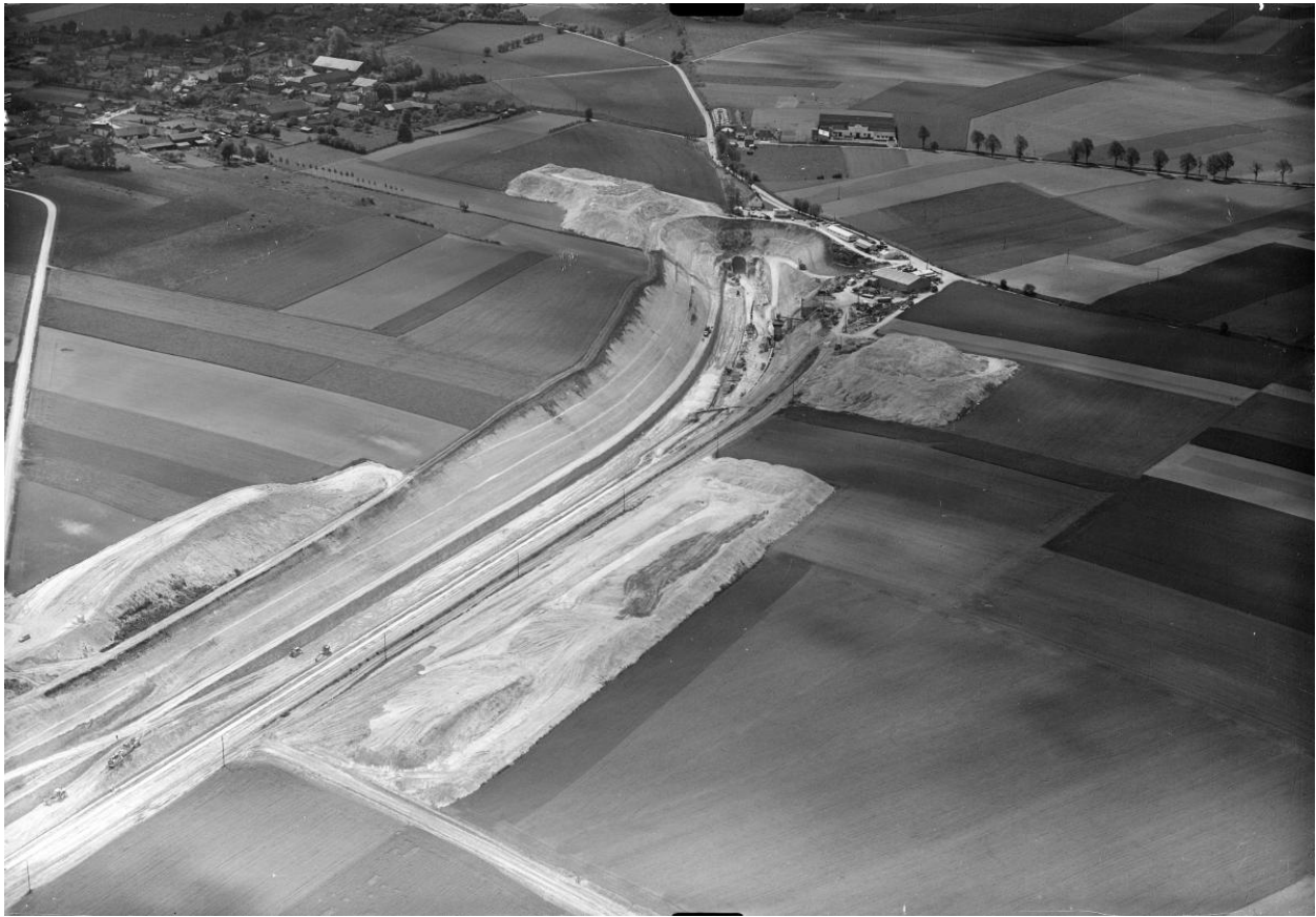
Vue aérienne de la tête nord du souterrain de Ruyaulcourt (Pas-de-Calais). (IGN. Photothèque Nationale.1965).
