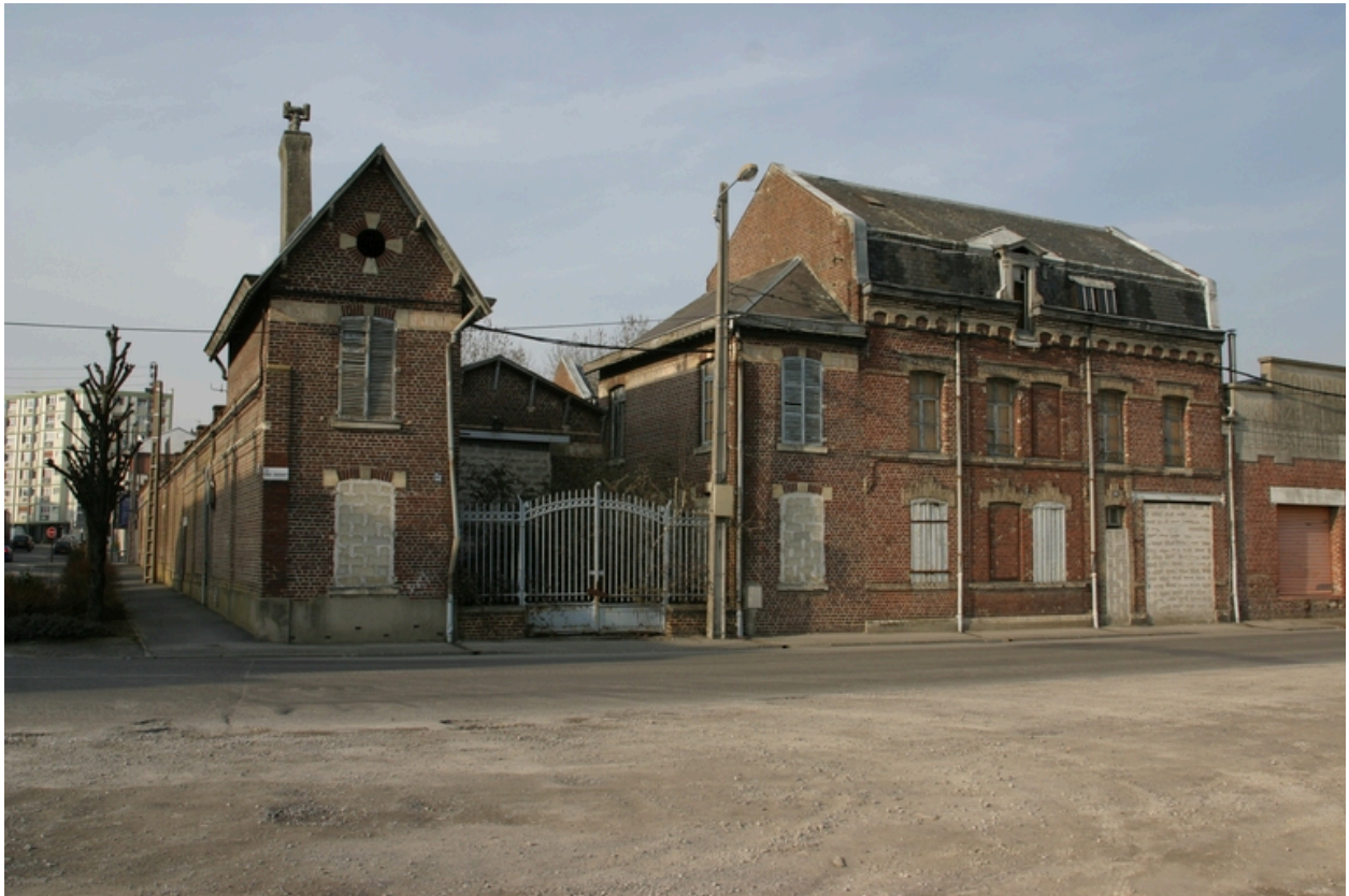
Façade antérieure, quai Gayant.
