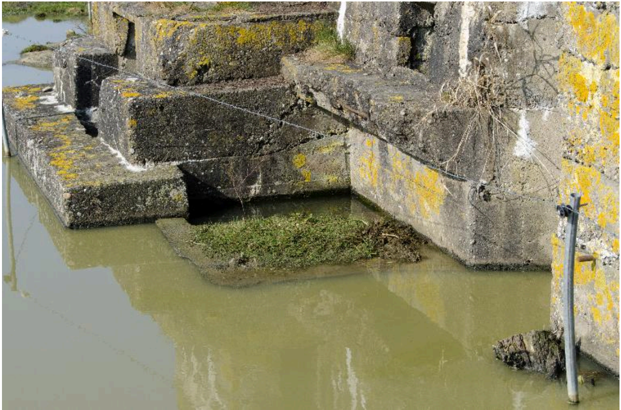
Elévation sud. Détail d'un puisard
