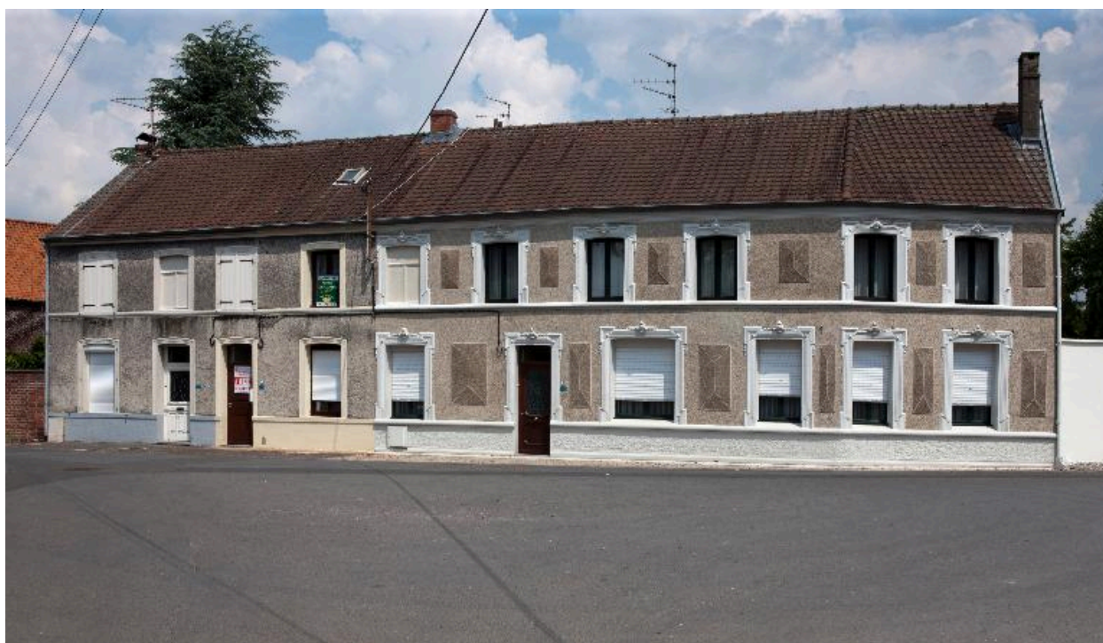
Maisons en alignement, rue de l'Eglise.
