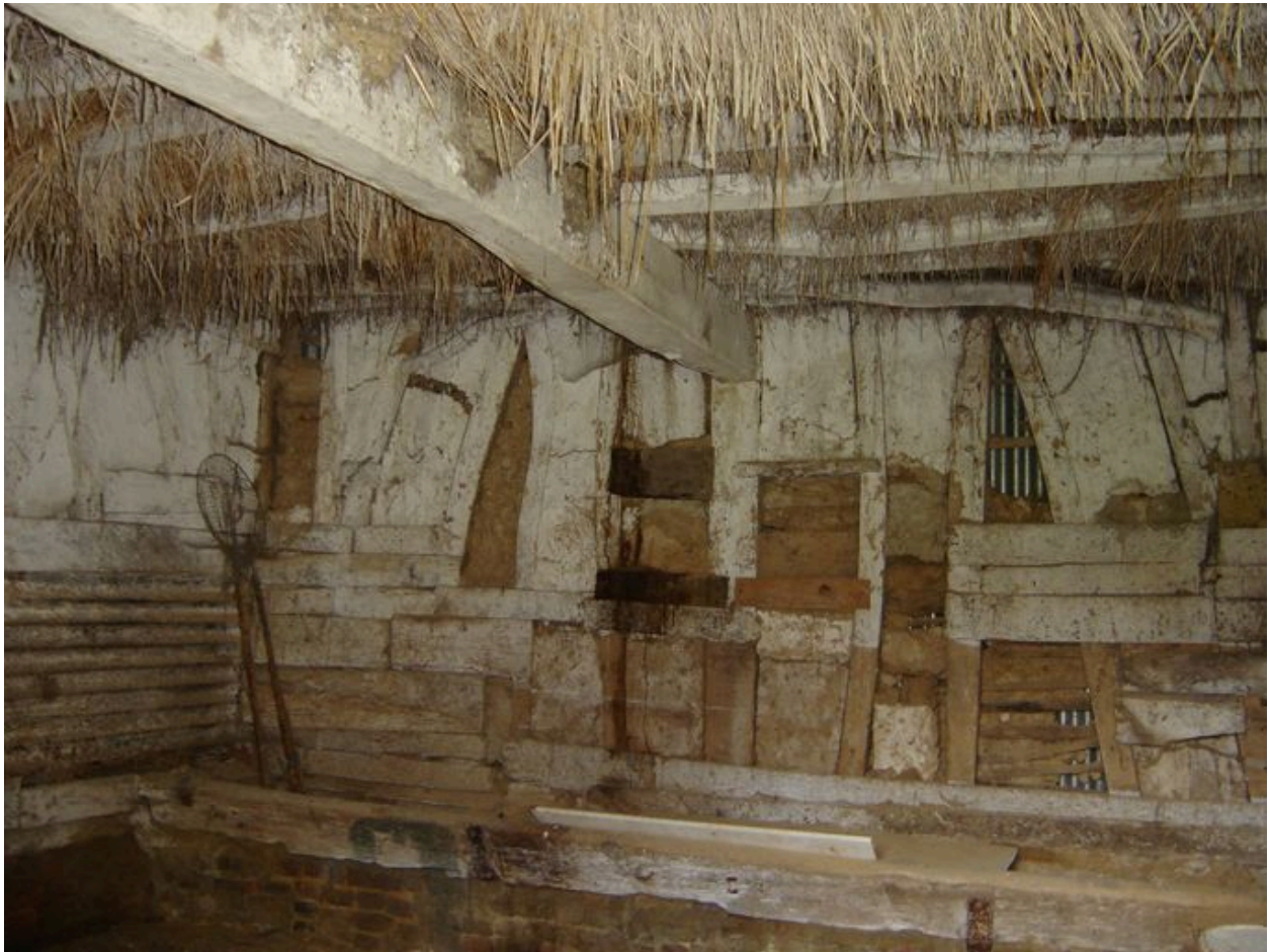
Vue intérieure des étables.
