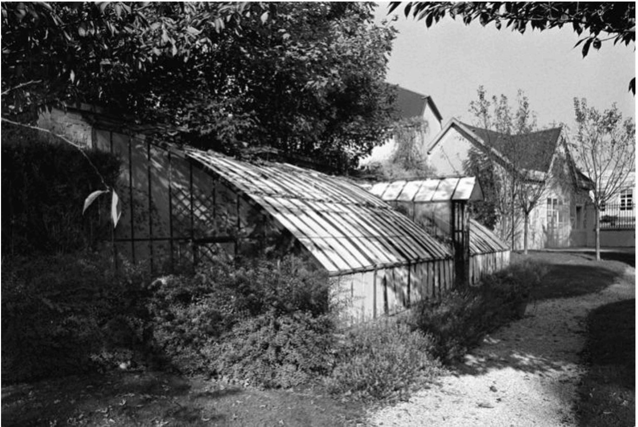
Vue d'ensemble de la serre.
