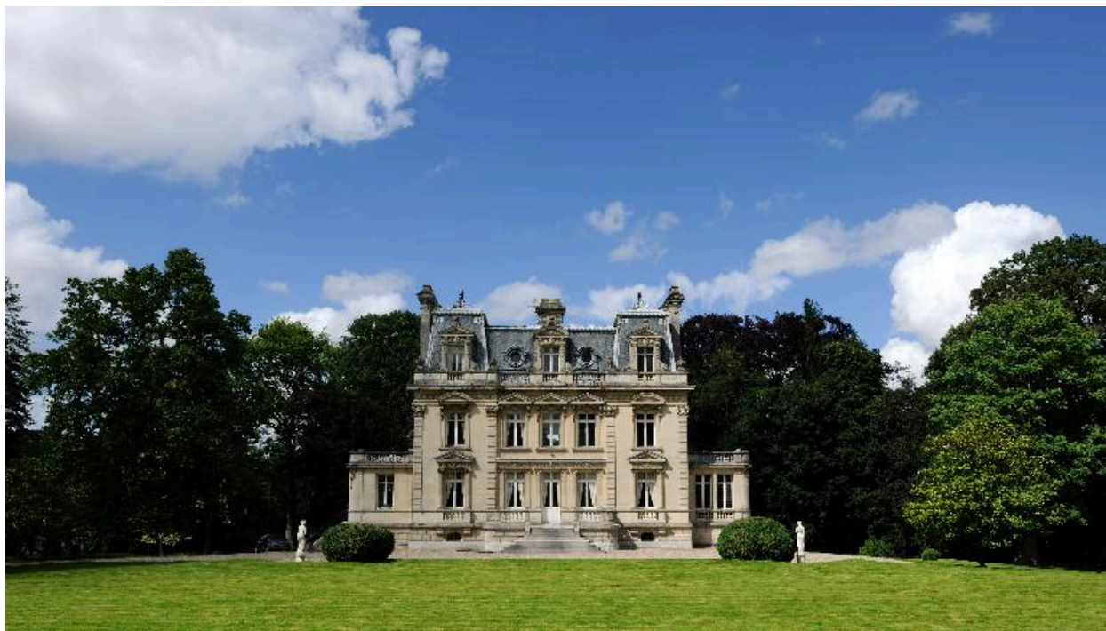
Façade arrière du logis sur parc.
