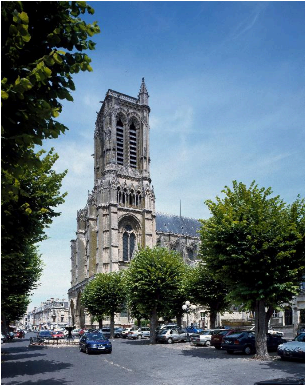
Vue de la tour sud-ouest.
