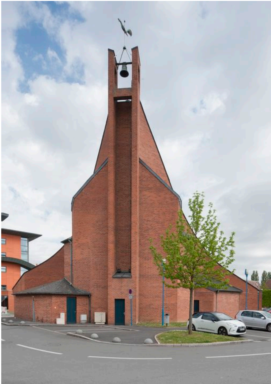
Façade postérieure. Vue générale.
