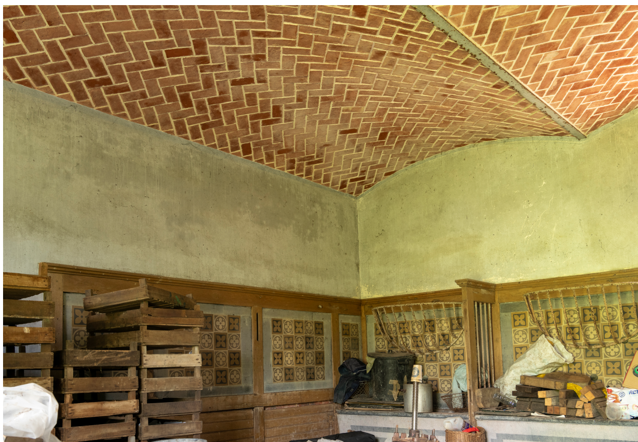
Intérieur des écuries.
