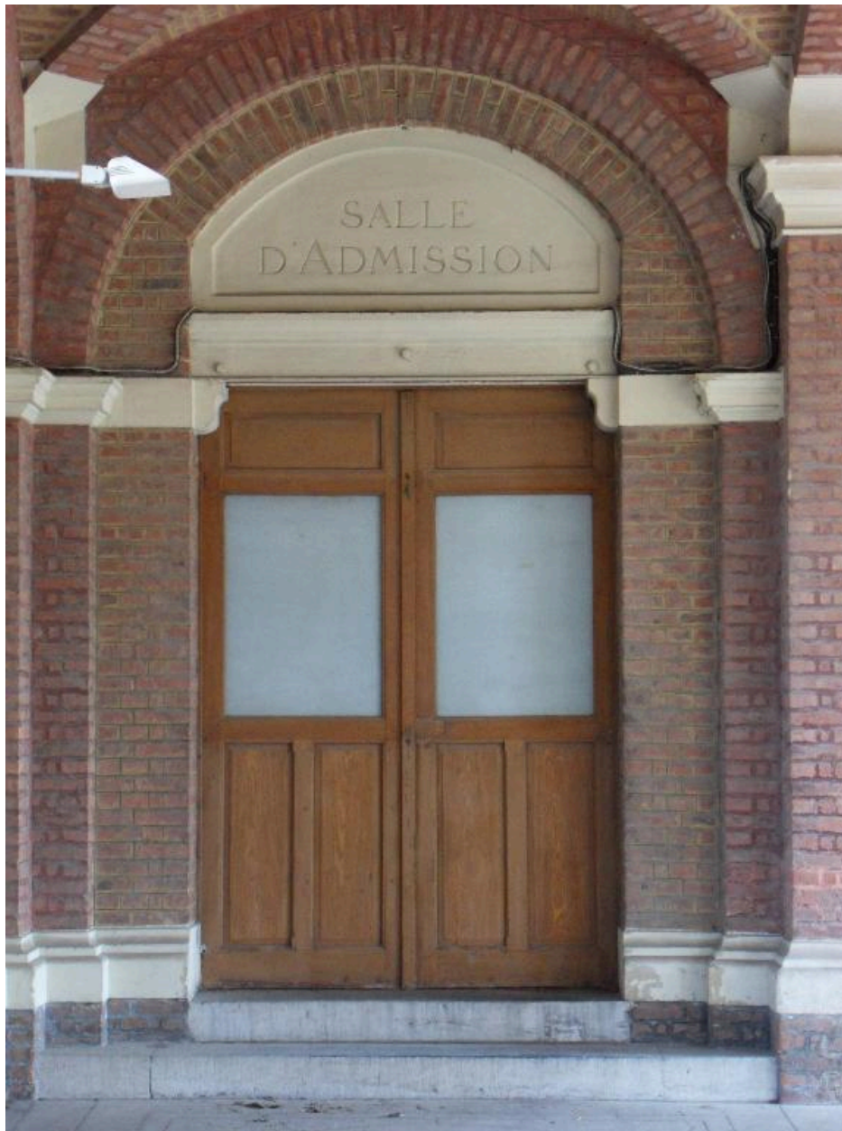
Bâtiment de l'administration. Porte de l'ancienne salle d'admission.
