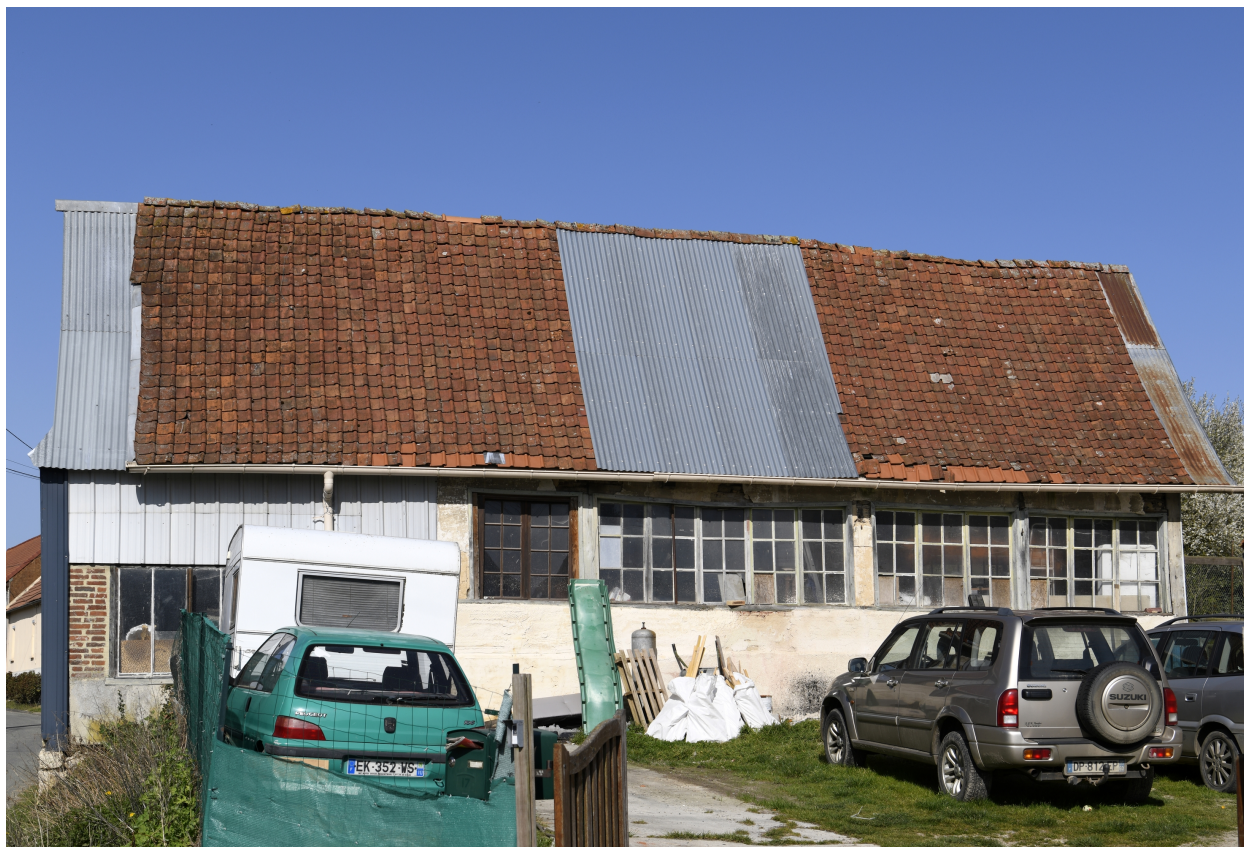
Anciens ateliers (fabrique de boutons de nacre ?), n°17 rue d'Hardivillers (sur le carrefour). Vue prise depuis l'est.
