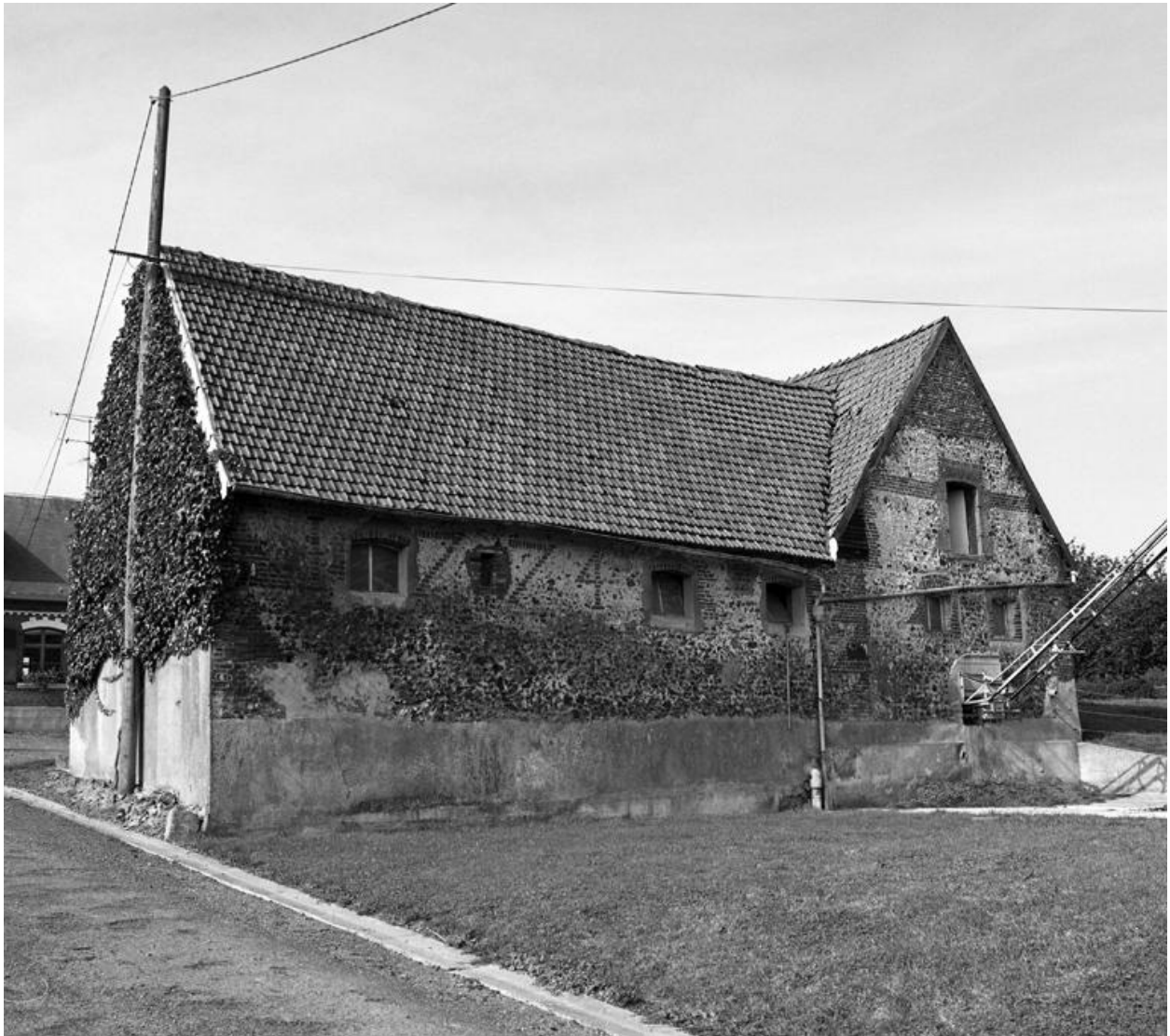
Les étables. Vue sur la façade extérieure portant la date 1774.
