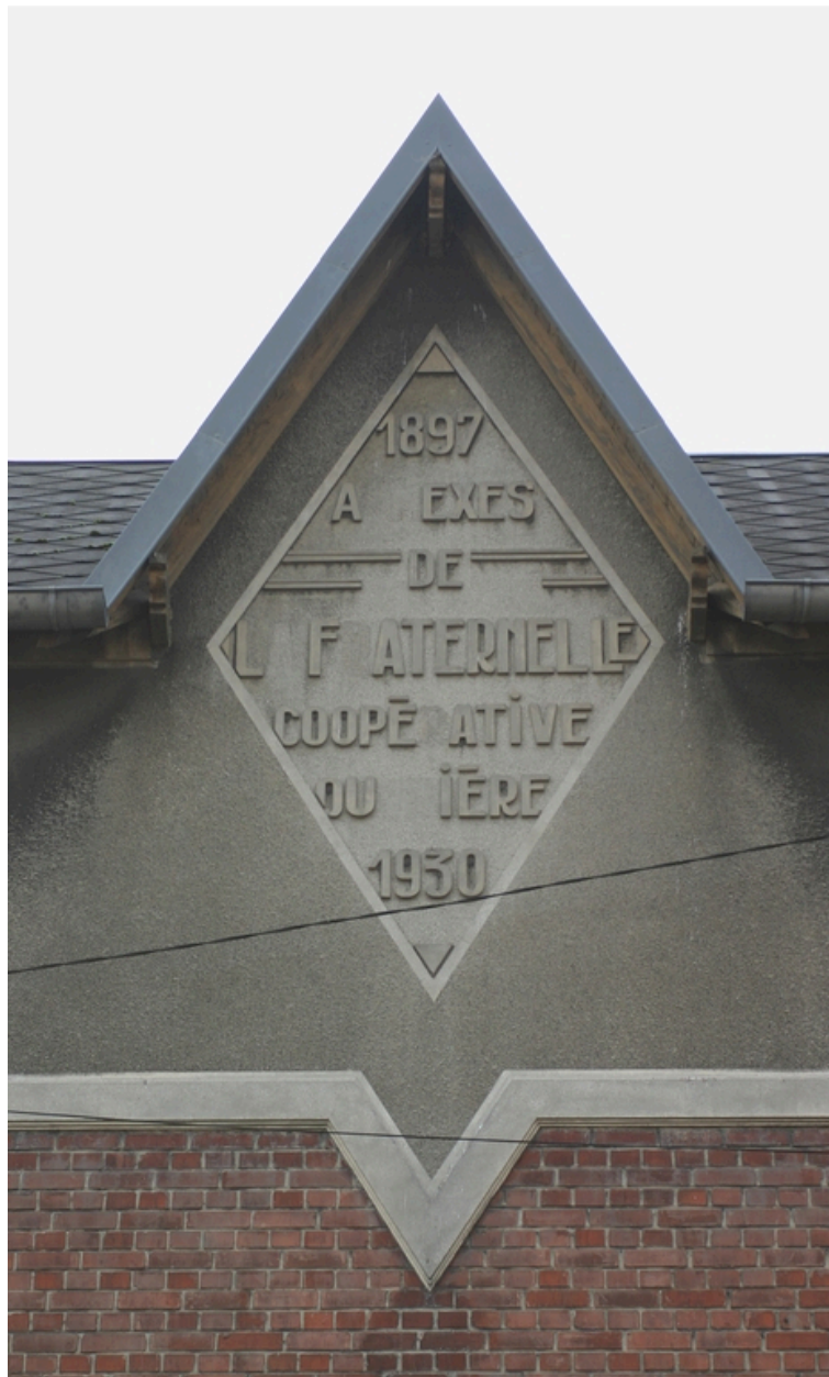
Détail de la façade sur rue.
