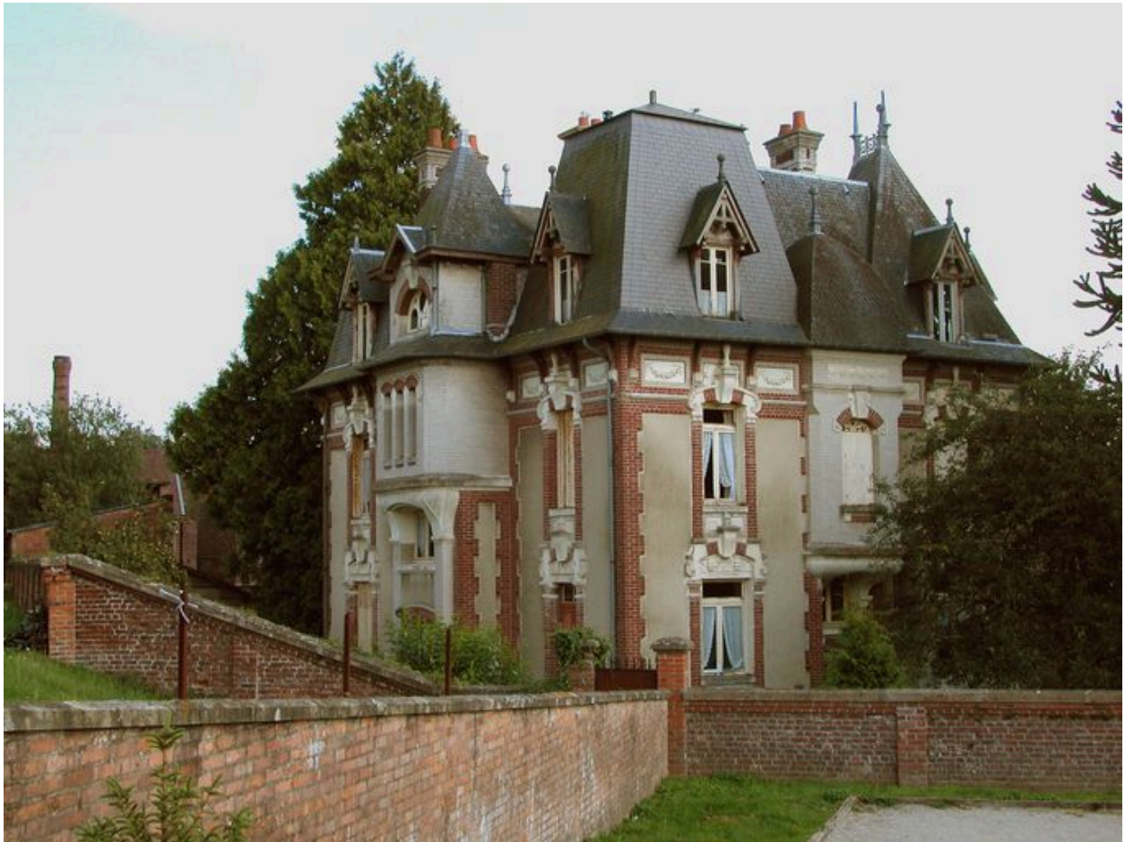
Le logement patronal, vue d'ensemble postérieur.
