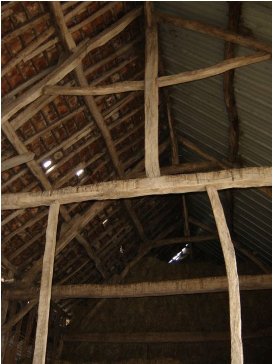
Détail de la charpente de la grange.
