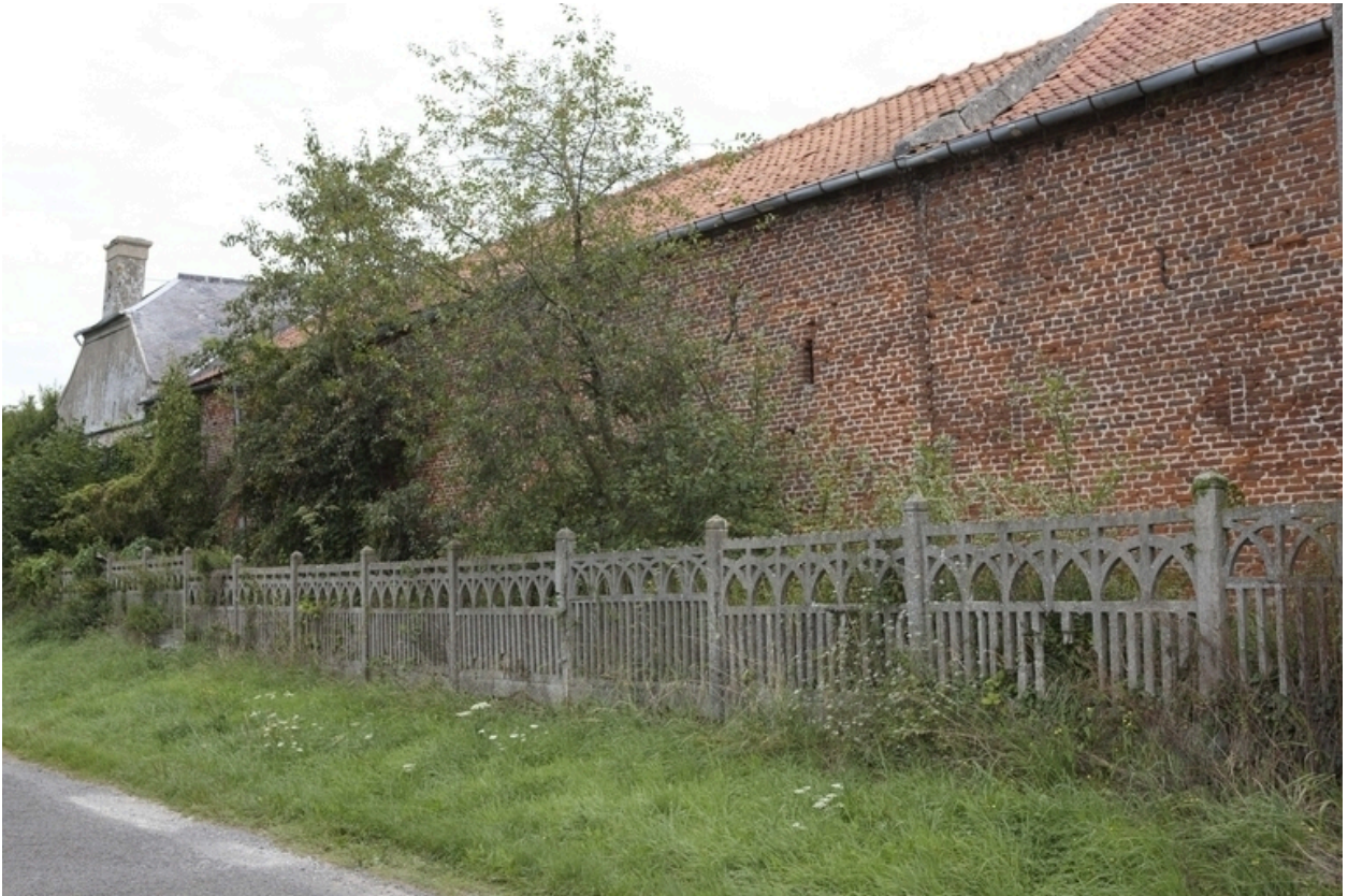
Vue du revers des écuries (sur la Grand'Rue) et du pignon du logis.
