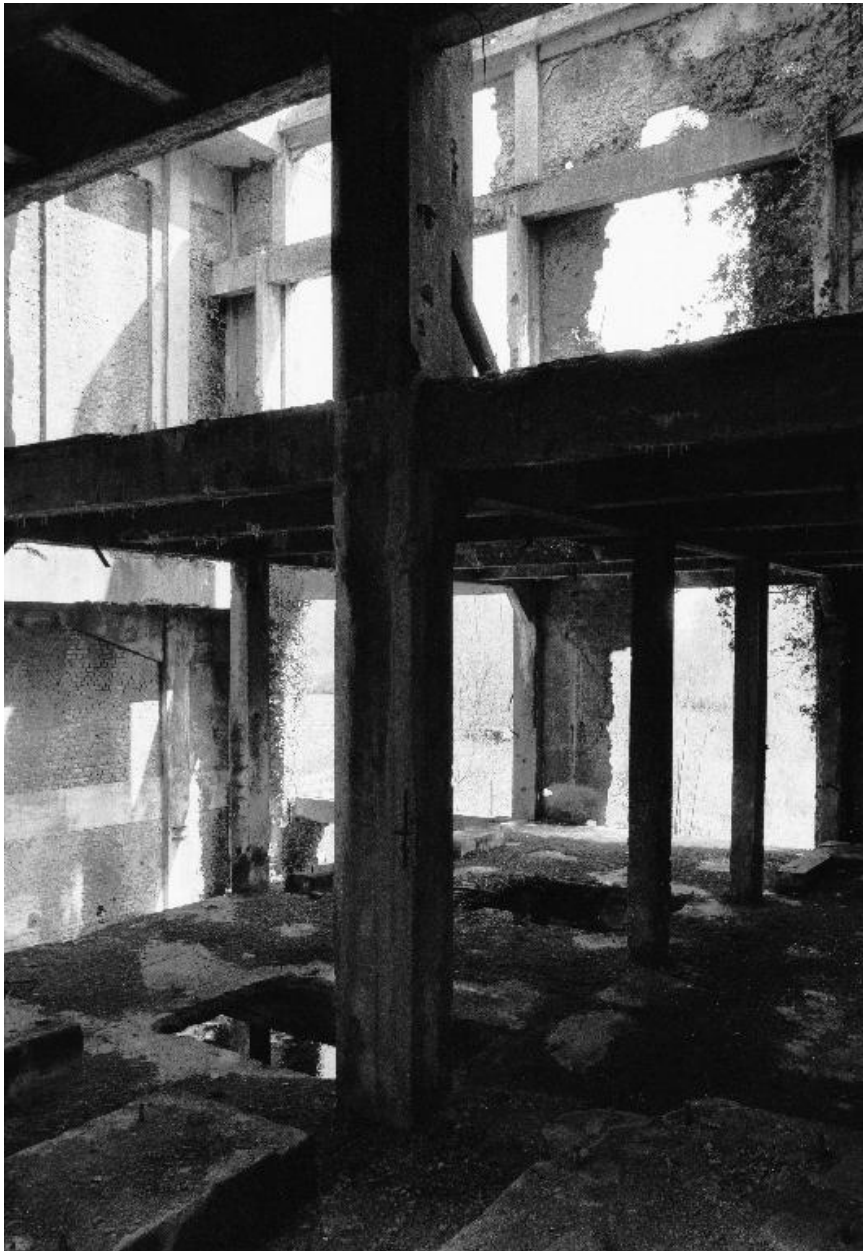
Atelier, salle des machines, premier étage.
