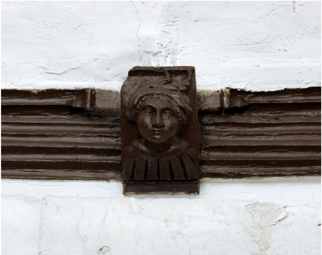
Détail d'un blochet.
