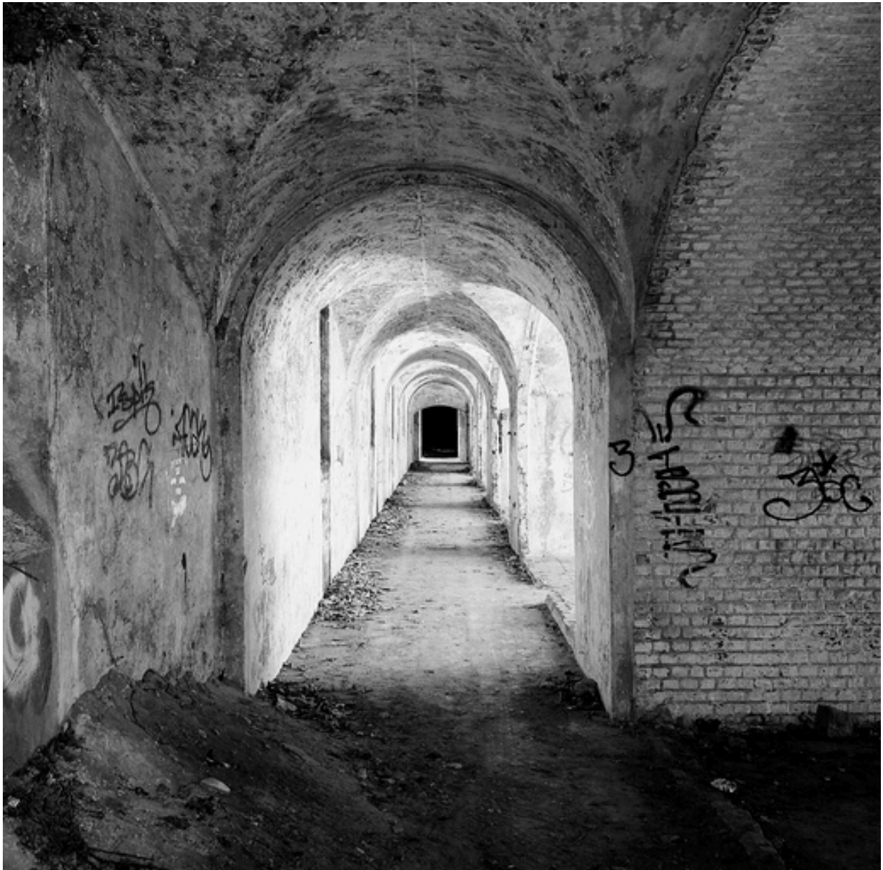
Casernement sud, le couloir desservant les salles.
