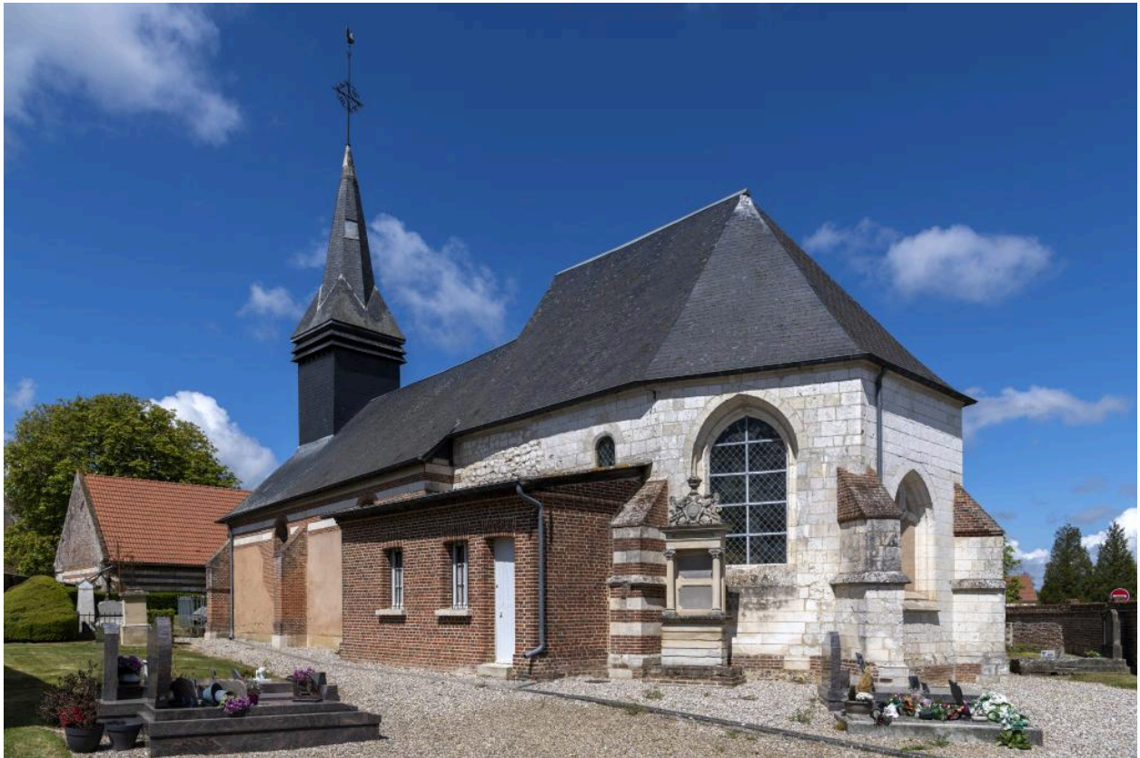
Vue depuis le sud-est: sacristie et chevet.
