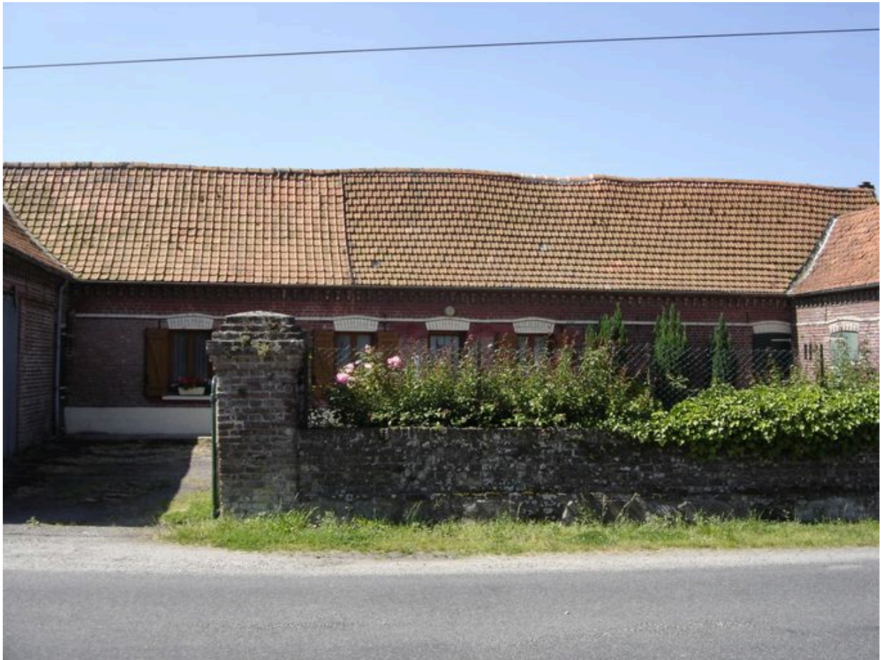
Vue sur le logis en fond de cour.
