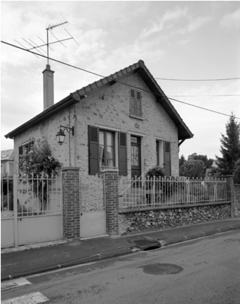
Vue de la façade sur la rue.
