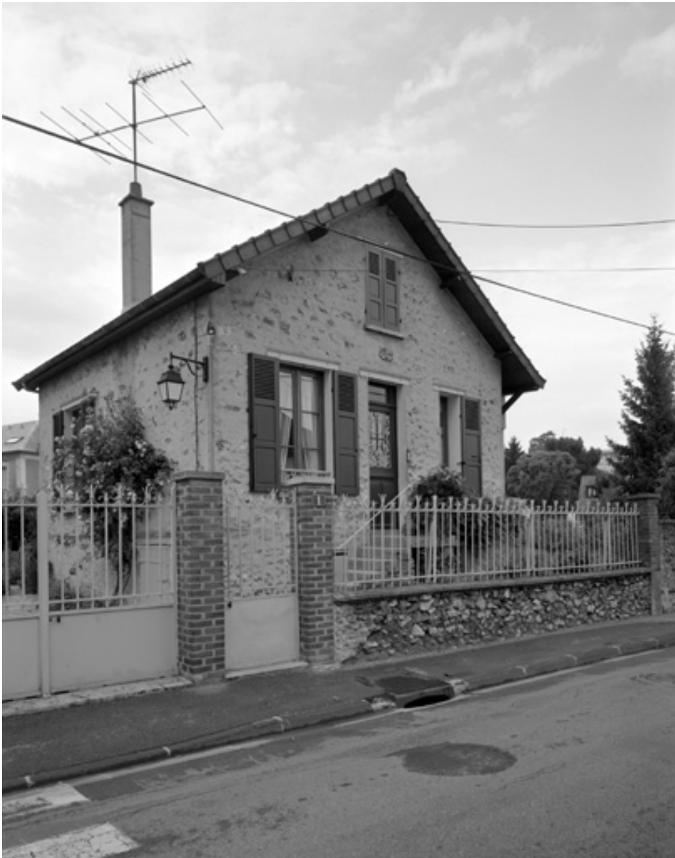
Vue de la façade sur la rue.
