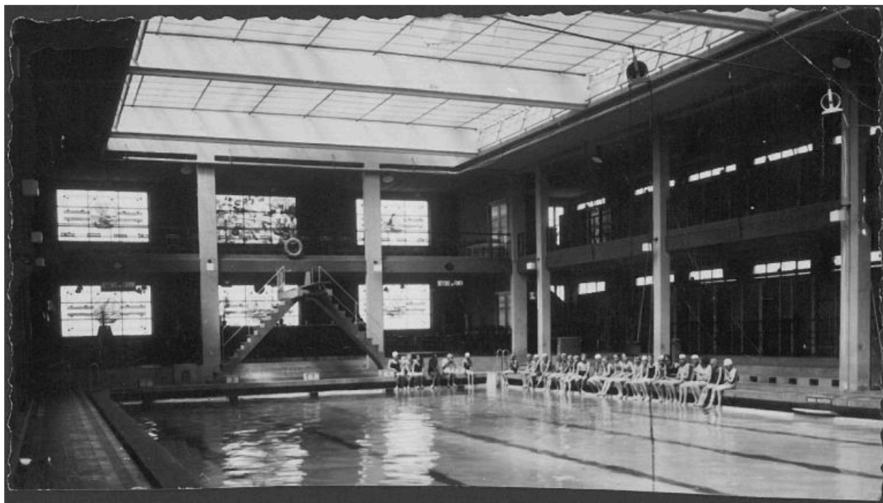
Vue intérieure de la piscine pasteur de Maubeuge avant un cours de natation. Dans le fond, noter le plongeur et les vitraux représentant des scènes marines. Photographie, vers 1940 (AC Maubeuge).
