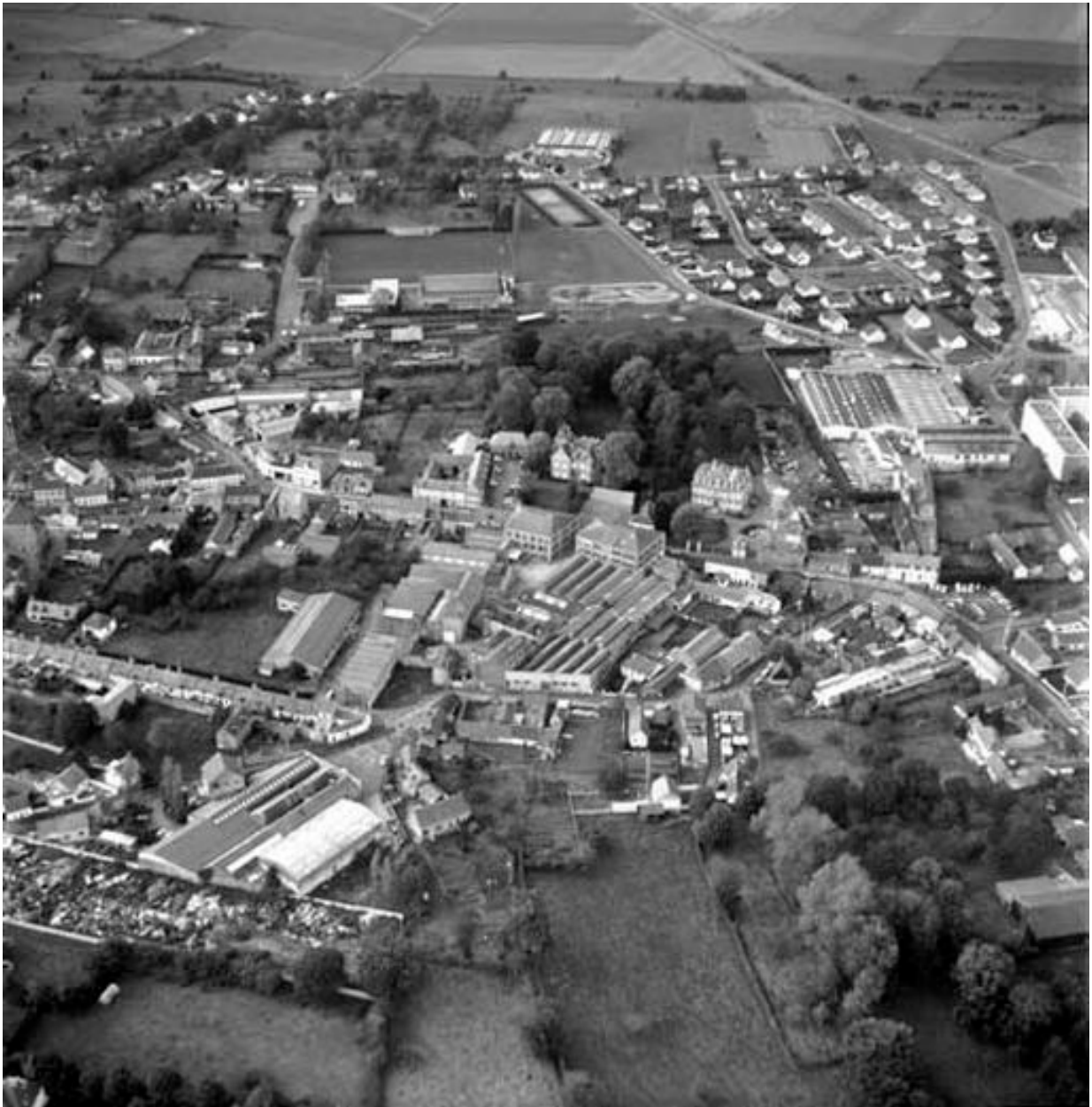
Vue aérienne nord de l'agglomération.
