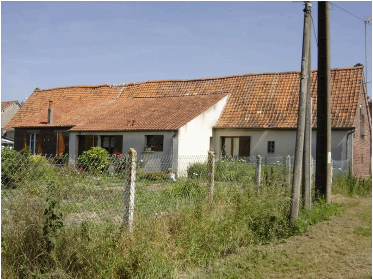
Vue sur la face ouest de l'ensemble.
