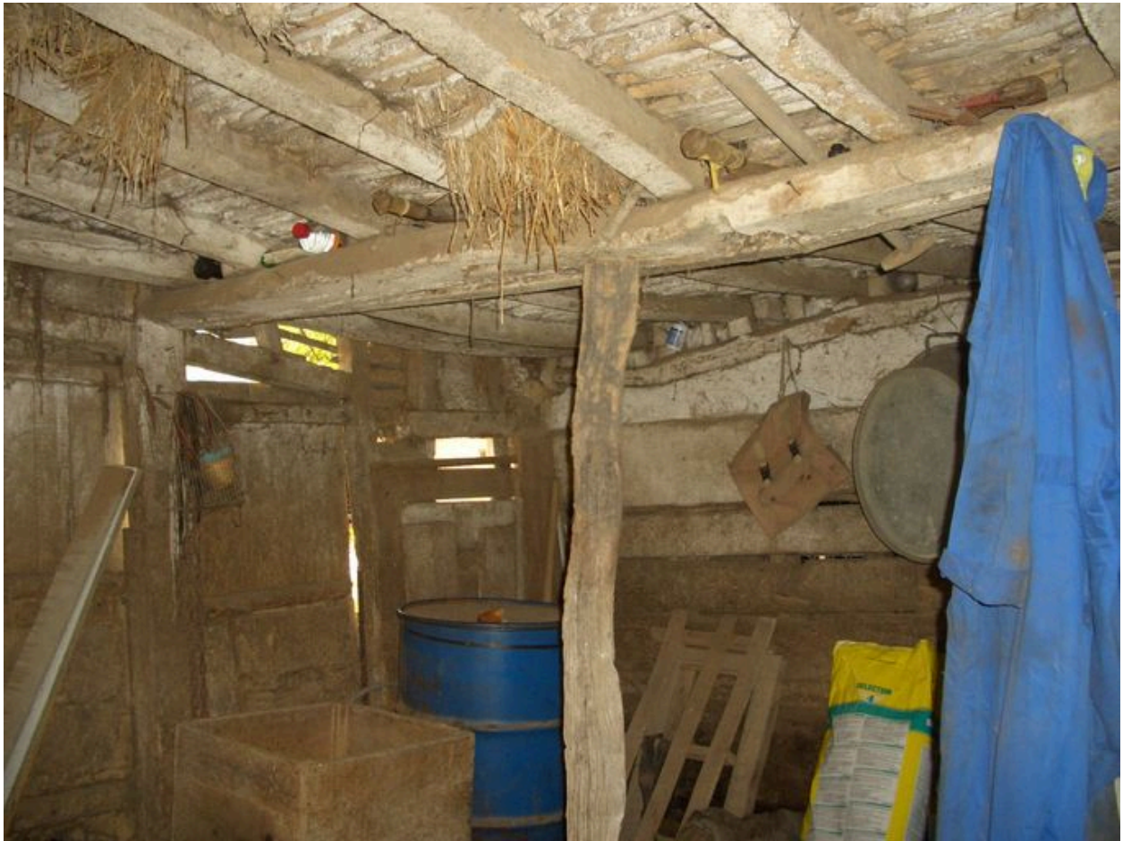
Vue intérieure des étables.
