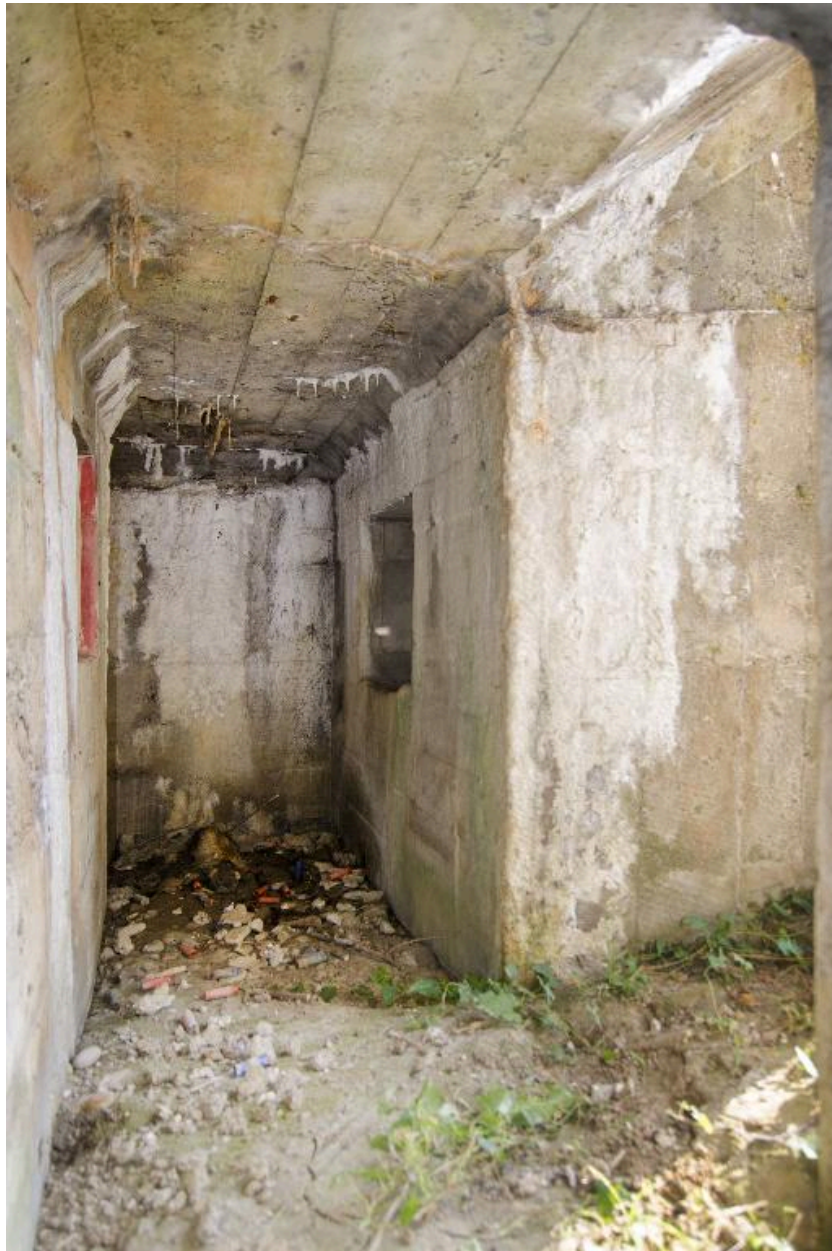
Couloir de distribution, vers l'est. A droite l'entrée et, au delà, le créneau de fusillade
