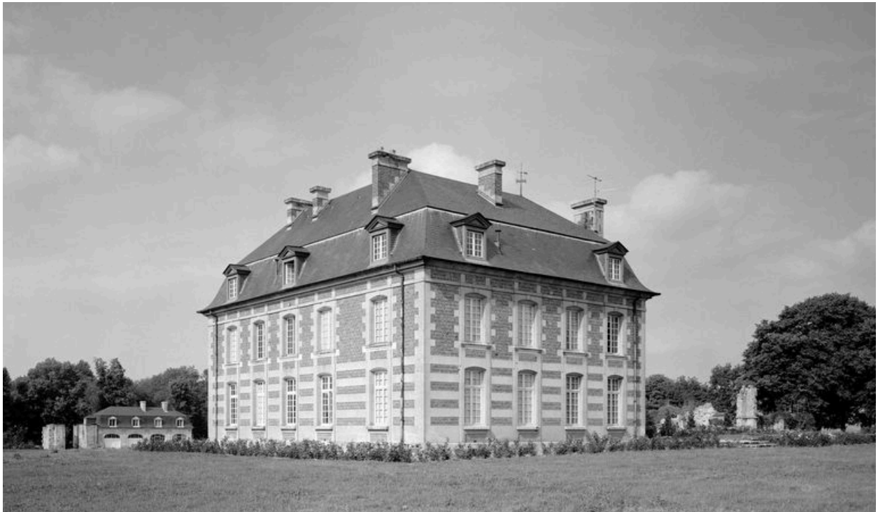
Elévation postérieure du château.
