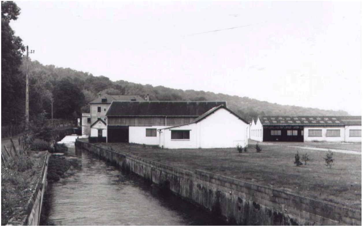
Vue d'ensemble du site industriel.
