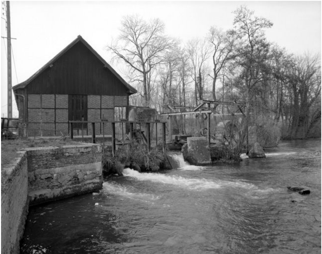
Vanne, roue, vestiges du bâtiment d'eau.
