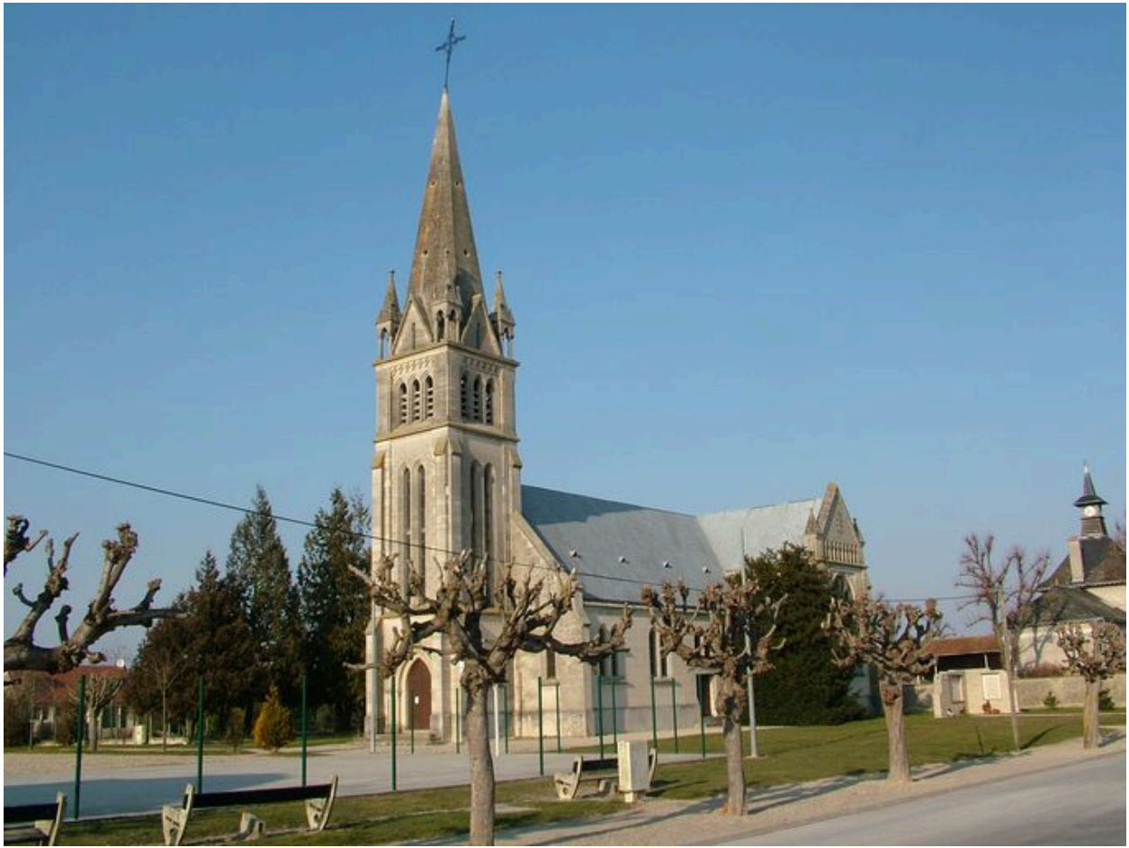
Vue générale de la façade ouest.
