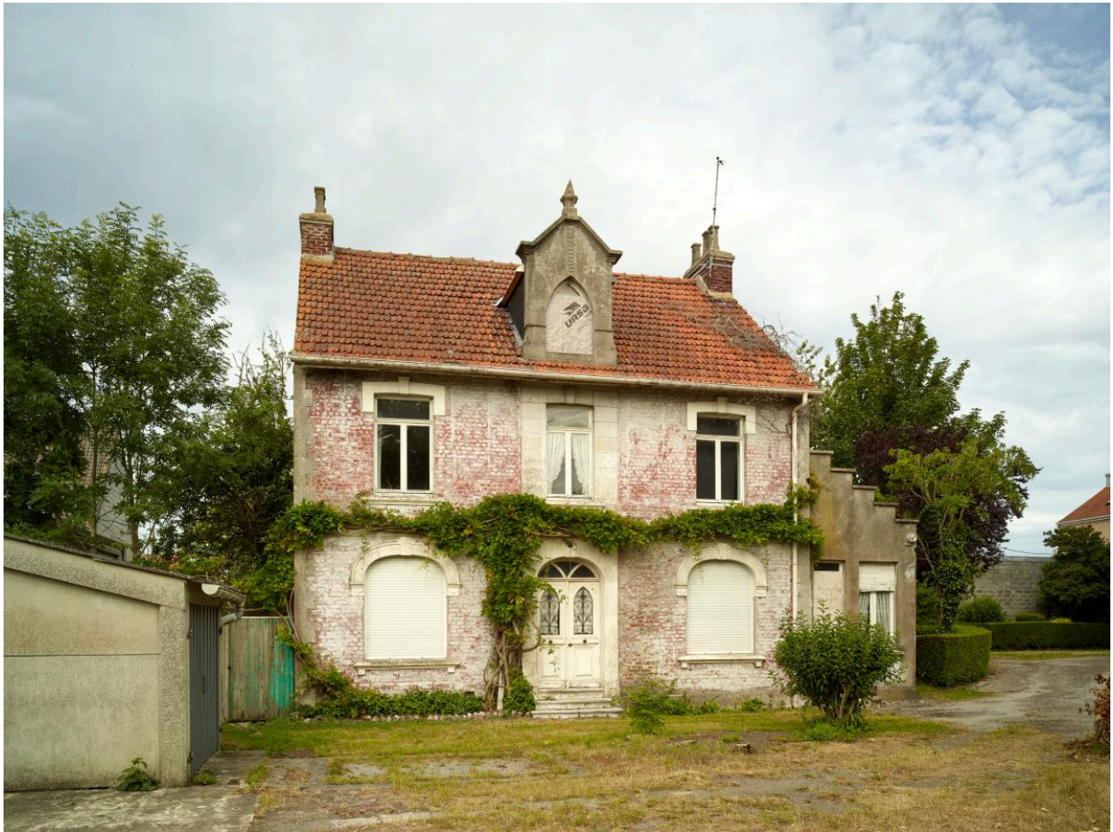
Façade est du presbytère.
